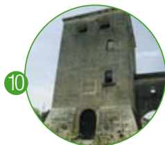
10 Torre Vella Old Tower Der Alte Turm
