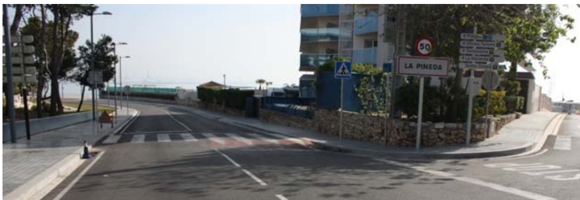
Foto. A la dreta s'observa part del carrer del Vaporet i al centre, un dels passos per a vianants peraltats.
